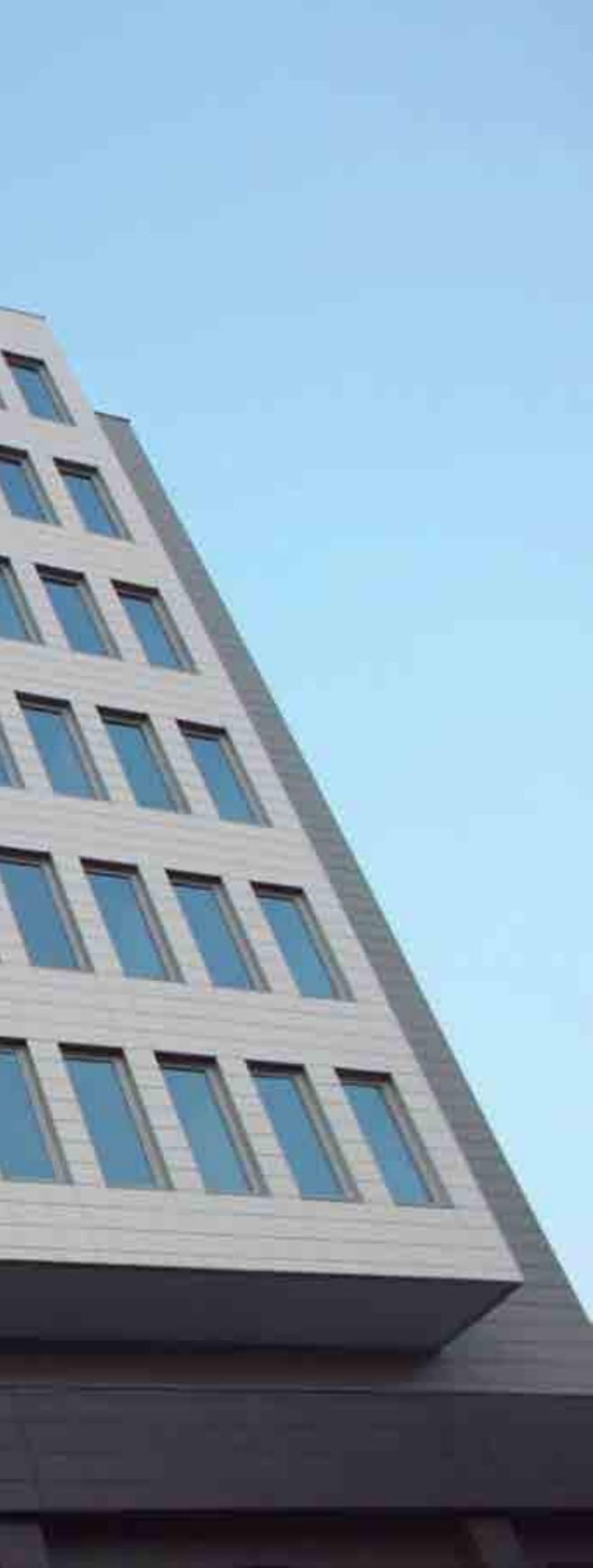
Proyecto/ Project : Doko Building. Elbasan (Albania)
