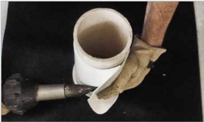
STEP 3. Tack weld NR
