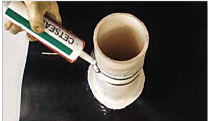
STEP 10. Install CETSEAL termination
