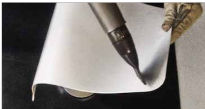
STEP 2A. Heat edge and stretch NR
